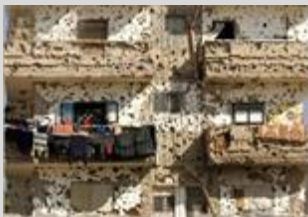
Fachada de um prédio civil parcialmente destruído em contexto de guerra.
